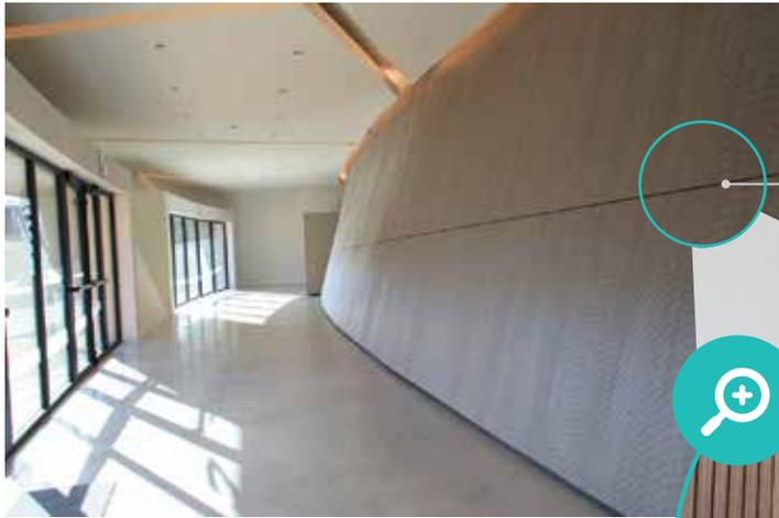
Pour la pose des panneaux en continu (supérieure à 3 mètres), nous demandons de marquer le joint avec un espace, et donc d'écartier les panneaux.
